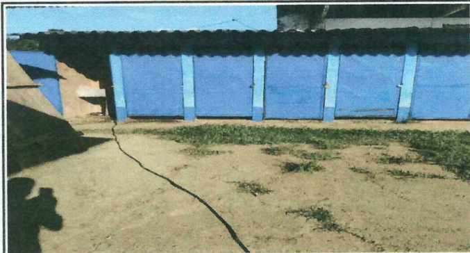
FOTOGRAFIA 1: SE NECESITA EL MANTENIMIENTO Y REPARACION DE BAÑOS SANITARIOS, YA QUE SE ENCUENTRAN EN MAL ESTADO Y LOS SANITARIOS CON FUGAS.
